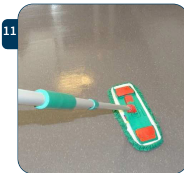
11 Maak het complete oppervlak klamvochtig met de oplossing I-Wax. Werk naar de deur toe. Let op! Spoel de mop zéér regelmatig in de grijze emmer.
