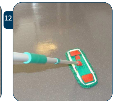
12 Laat het oppervlak grondig drogen. In deze fase kunnen deuren en ramen open voor een snelle droging. Eventueel nadien droog moppen kan.
